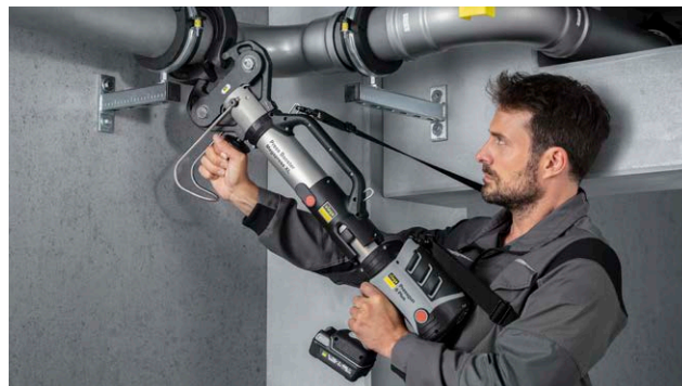
Pressare l'acciaio a parete normale fino a 4": Pressgun 6 Plus con Pressgun-Press Booster.
