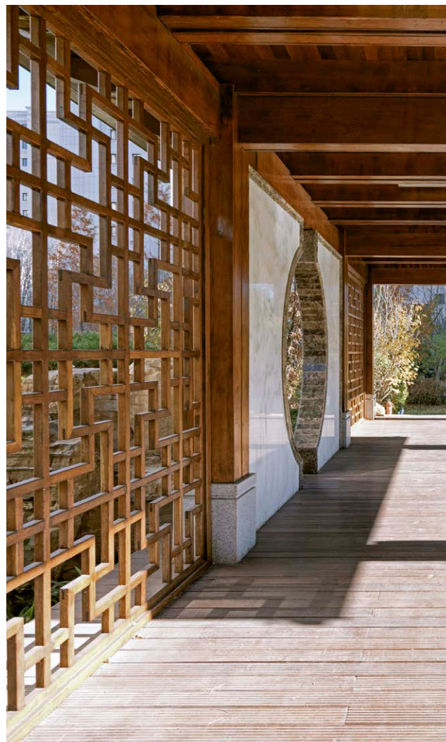
Architettura moderna in armonia con elementi di design tradizionali.
